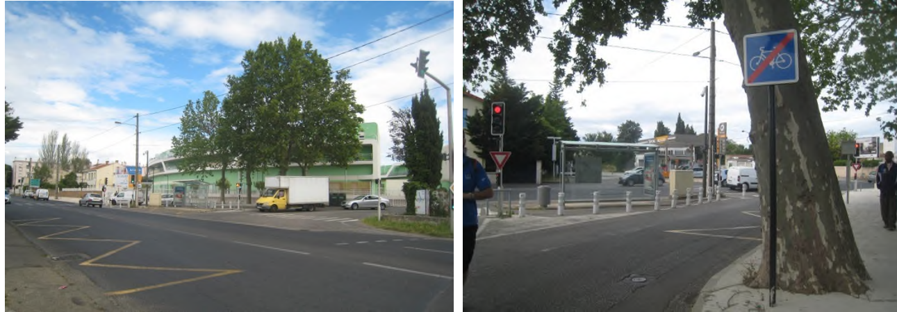
Carrefour Av. Pierre Mendès France / rue des Platanettes avec vue sur la résidence Aristéa en arrière-plan
