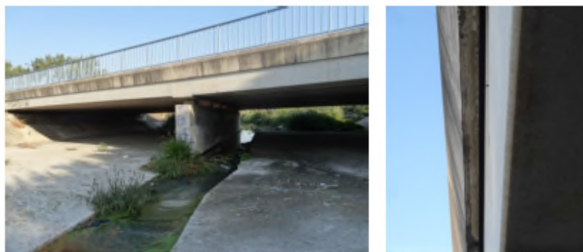
Vues du pont favorable aux chiroptères
