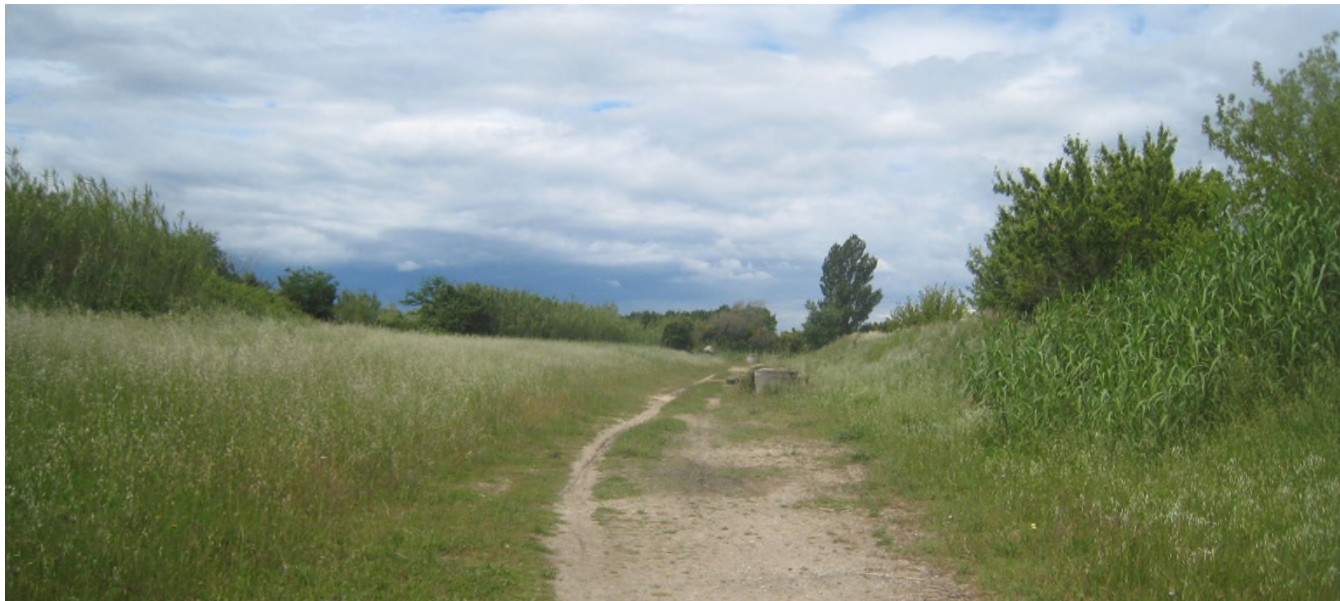
Délaissés entre merlon de l'autoroute et digue avec réseaux en attente
